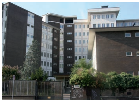
La sede della RSA in via di Rudini 3
